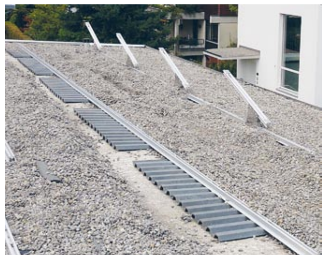
Einbau der Flachdachaufständerung und Beschweren der Druckverteilungsplatten mit Rundkies
